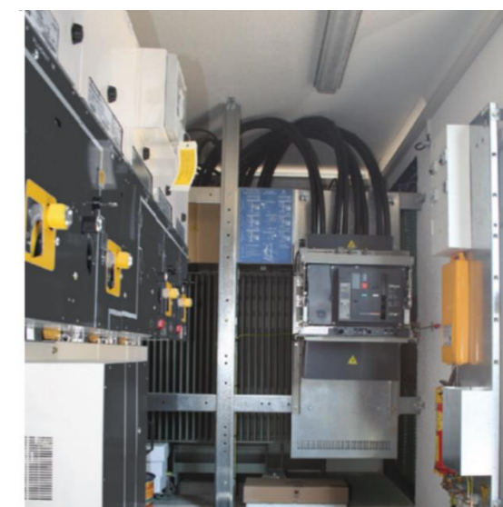
Exemple de poste de transformation, photo d'un transformateur et de l'intérieur d'un poste
