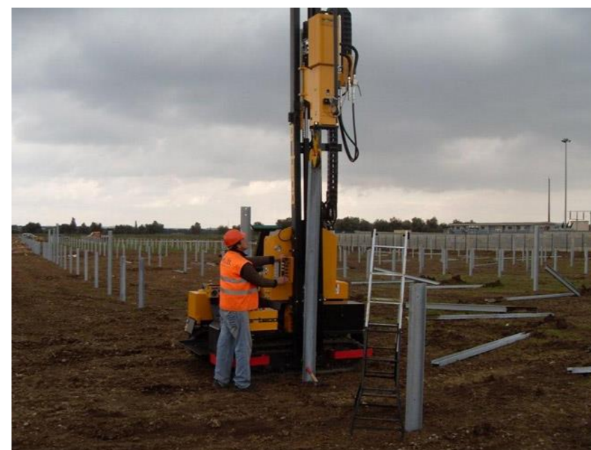
Exemple d'enfoncement de pieux battus pour la mise en œuvre d'un parc photovoltaïque
