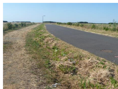
Avenue des Vallées : voie de desserte interne à la ZAC, à l'ouest du site de projet
